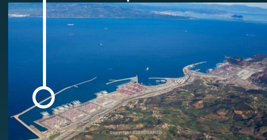
Tanger Med Port Breakwater
